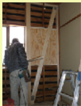
窓を撤去して、筋交いと耐震金物で耐力壁を作る。
