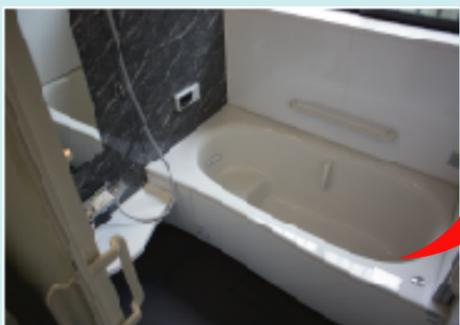
水廻りのリフォームも兼ねて、お湯や水・排水の配管などもすべて新しく交換します。ユニットバスに入替して、断熱材もたっぷり。
