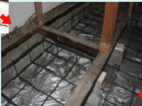
既存の布基礎に、鉄筋で補強します。新しい基礎を古い基礎に抱き合わせて強くします。
