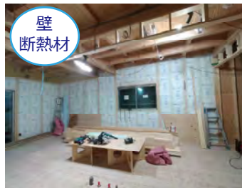
壁断熱材 高性能グラスウール16K 厚み90mm
