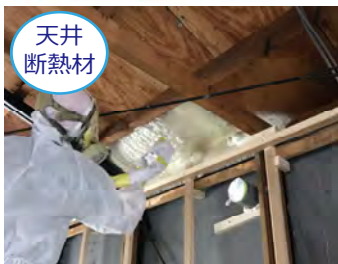
天井断熱材 吹付ウレタンフォーム 厚み180mm
