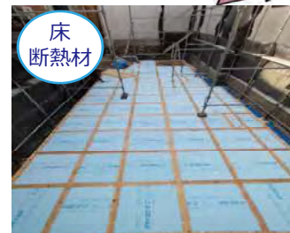
床断熱材 スタイロエース 厚み65mm
