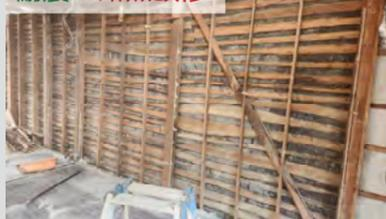
耐震基準が満たされていない弱い壁。断熱材も施されていない。
