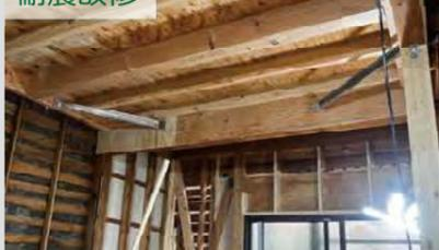
金物や梁の補強・床組み強化
